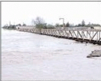
Ciudad Insurgentes.- Las fuertes lluvias que se registraron en esta zona provocaron que las viviendas fueran inundadas por las aguas de la tormenta tropical Julio. (S. G. López)
