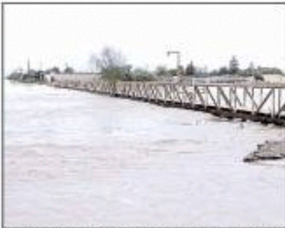
Ciudad Insurgentes.- Las fuertes lluvias del sábado que ocasionaron las severas lluvias provocadas por la intensa fuerza que se registraron el pasado fin de semana en esta zona al paso de Julio. (SUDCALIFORNIANO)
